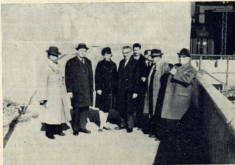
Vor dem Wasserkraftwerk in Wolgograd
